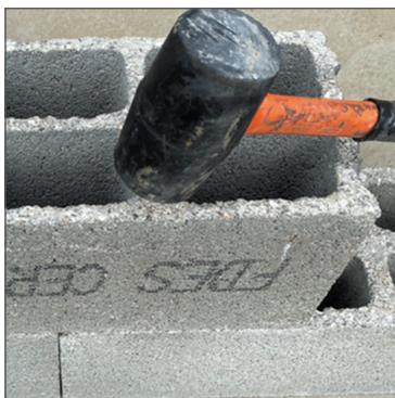
Tapoter ensuite légèrement à l'aide d'un maillet en caoutchouc pour assurer un bon contact entre les blocs béton. Le temps d'emploi de la colle doit être inférieur à 8 minutes.
